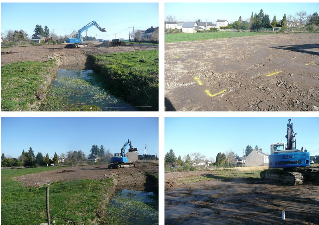
Figure 7 : Photographies du site pendant la réalisation des travaux de recouvrement
