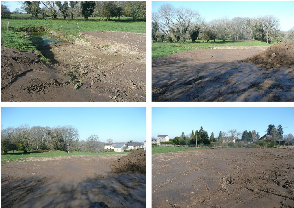
Figure 8: Photographies du site après la réalisation des travaux de recouvrement (état final)
